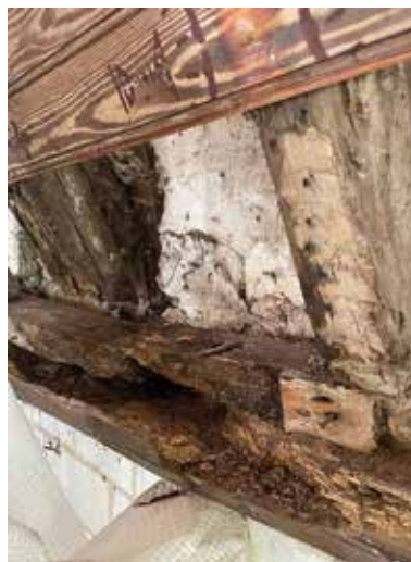
Etat de la sablière avant remplacement
