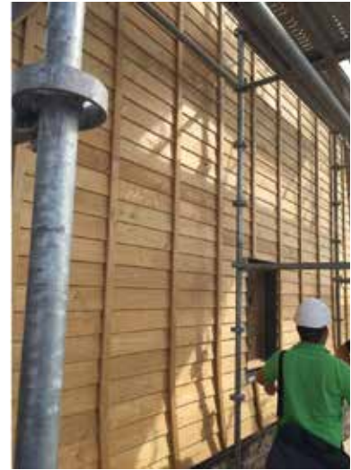
Bardage en bois : ajout des pièces de bois sur le pignon
