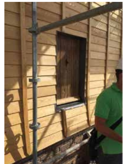
Bardage en bois : ajout des pièces de bois sur le pignon
